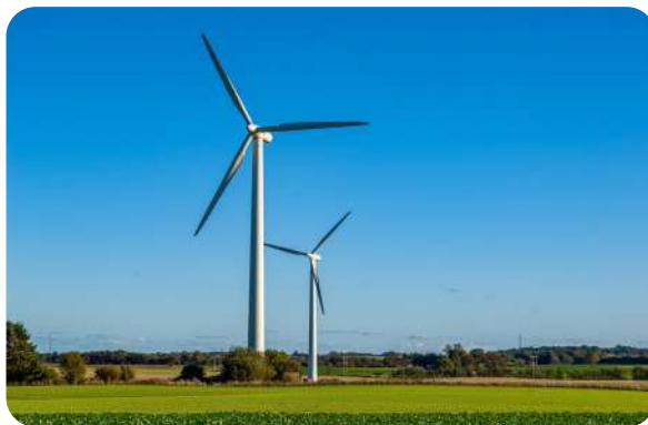
Turbinas de energia eólica em Hovedgaard, Dinamarca, 2021.
