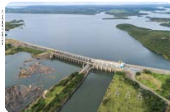
A construção de uma usina hidrelétrica implica o alagamento de uma grande área. Na foto, vista aérea da Usina Hidrelétrica de Lajeado no rio Tocantins, Tocantins, 2021.
