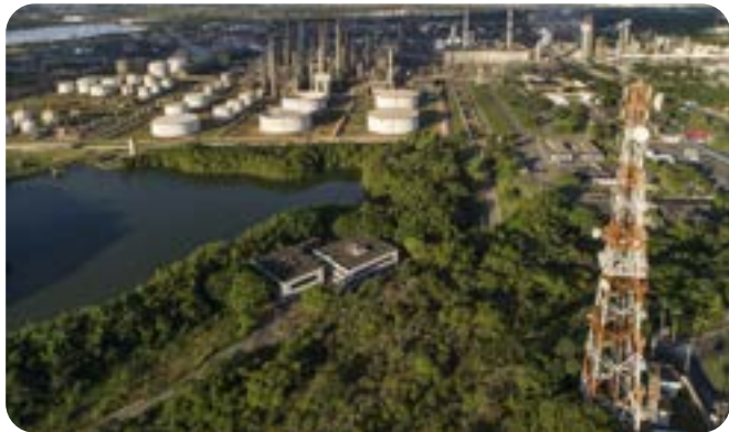
Complexo petroquímico no polo industrial de Camaçari, Bahia, 2017.
