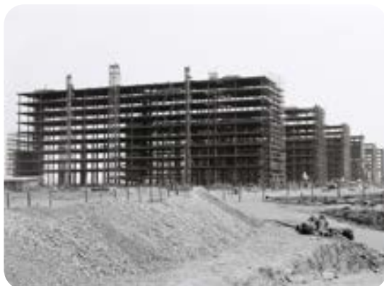
Construção de Brasília. Na foto, prédios ministeriais em 1959.
