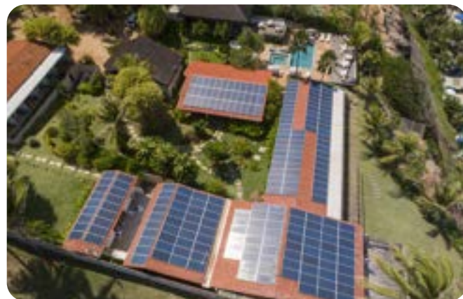
Vista de telhado de hotel com placas fotovoltaicas em Tibau do Sul, Rio Grande do Norte, 2022.
